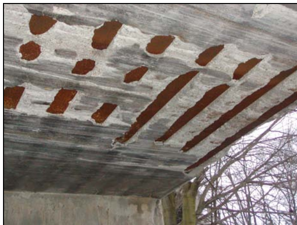
Pohled na poruchy ve spodním líci nosné desky
